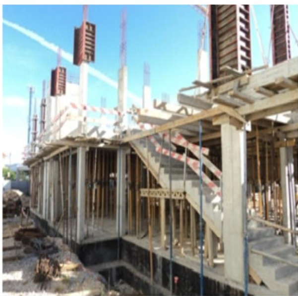
Bloco C: descofragem pilares piso 1 e lançamento vigas de cobertura
