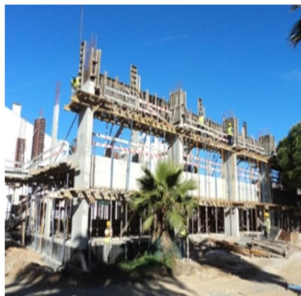
Bloco C: descofragem pilares piso 1 e lançamento vigas de cobertura
